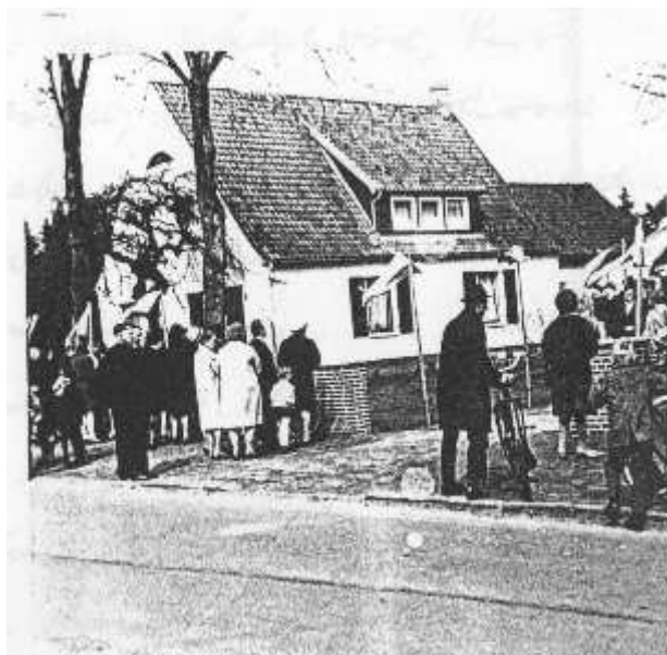
rechts: nach der Renovierung 1969, mit vergrößertem Dachker
