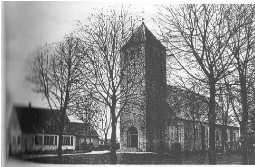
Die Kirche in Marhorst nach der Renovierung 1949 mit neuem Turm und Verlängerung des Kirchenschiffs um 1 Joch.
